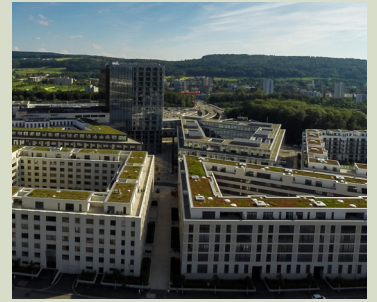
Begrünte Dächer sind ein wesentliches Mittel zum Schutz vor städtischen Problemen.
