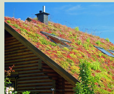
Einige Standortfaktoren können nicht geändert werden, wie z. B. die Dachneigung.
